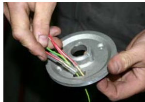
Passer les câbles de sortie du stator par le trou de la platine.
